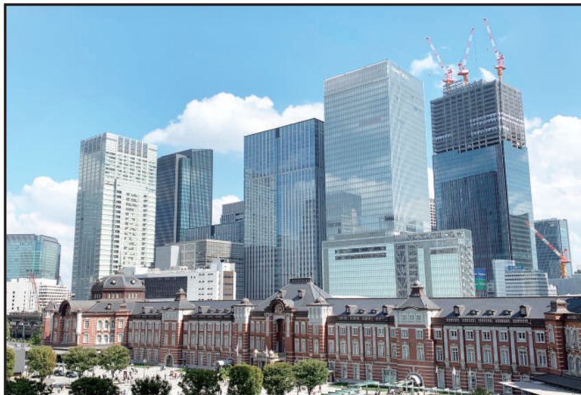
「東京駅丸の内駅舎と八重洲口ビル群」(編集部)
