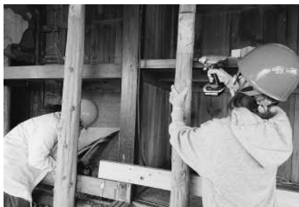
↑床板剥がし・束の交換・根太の補強（2022年7月～2023年1月）
