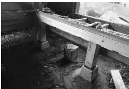
↑床板剥がし・束の交換・根太の補強（2022年7月～2023年1月）
