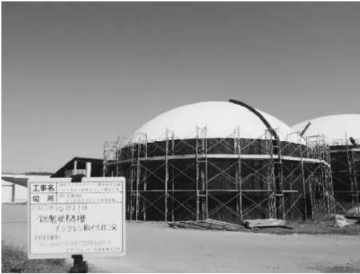
〈建設中の阿寒マイクログリッド 発酵タンク〉
