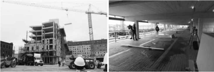
写真1 CLTと集成材を用いた8階建て共同住宅の建設現場
