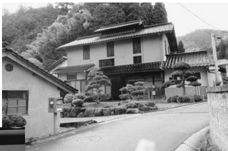
農家民宿「大屋大杉」の宿泊施設として利用されている空き家であった木造三階建て養蚕住宅
