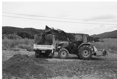
図6 削り取った表土の排出
