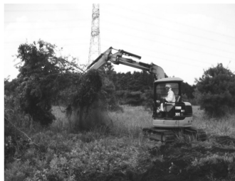
写真3 抜根作業
