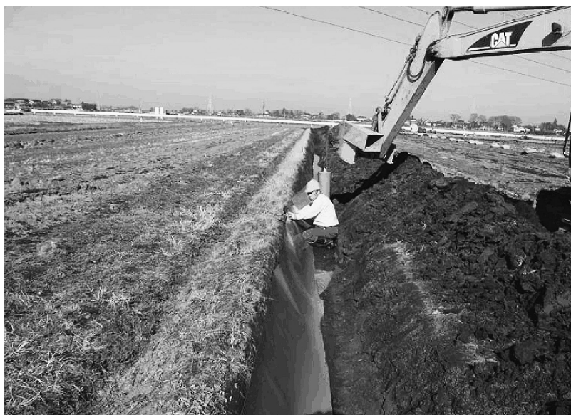
図4 漏水防止対策・遮水シートの施行
