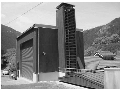
ボイラー室・チップサイロ全景
