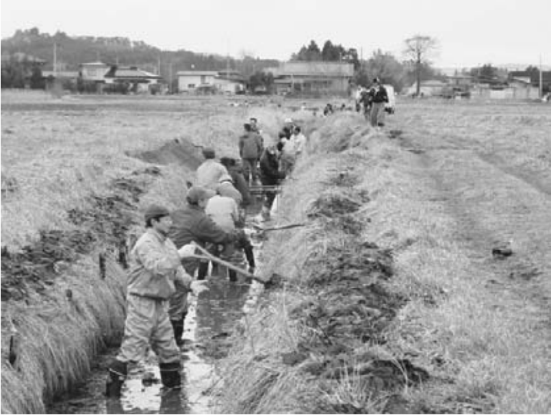
排水路の泥上げ
