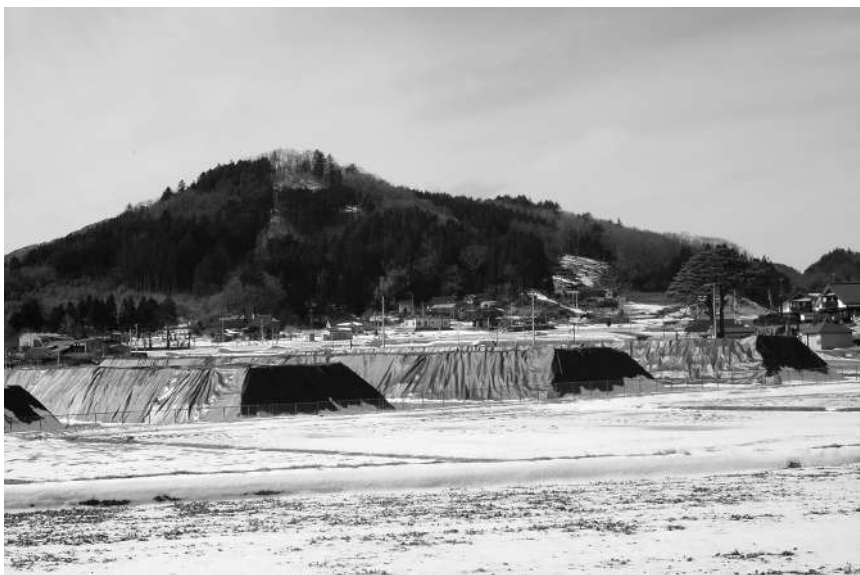
写真1. やがて撤去される除去土壌のフレコンバックの山と、除去できない土壌と樹木を抱える山。 飯館村 (2018年)、撮影糸長浩司
