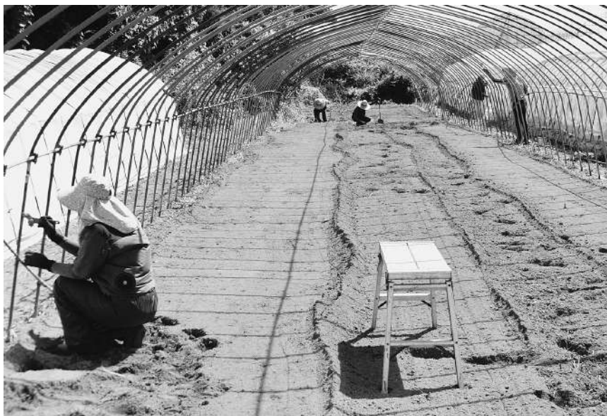
実習生によるハウスの補修作業
