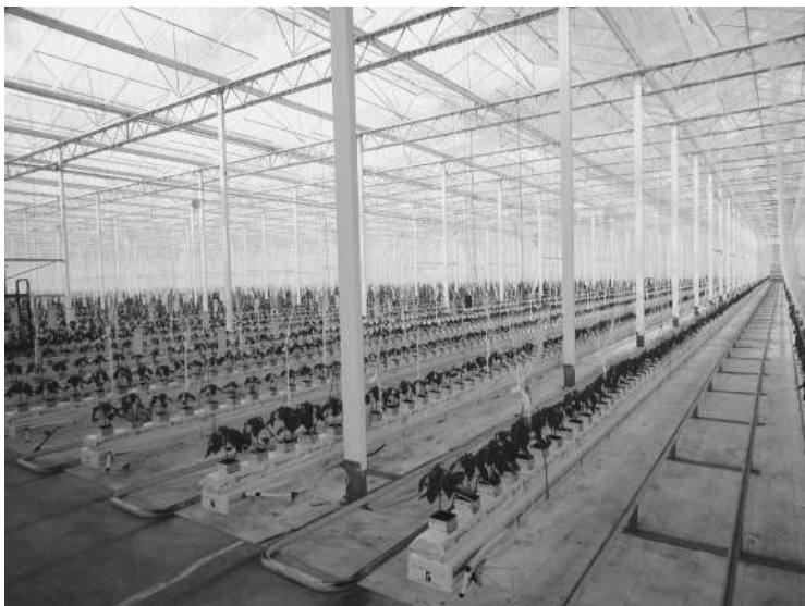
写真2 苗の定植が終わった第一温室内部（90 m×180m）。苗は、高さ5 mまで誘引する。
